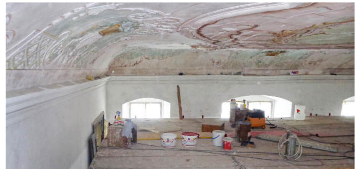
Oben: Die Stuckdecke war durch Risse stark beschädigt... ; Mitte, links: ...und musste wegen Absturzgefahr gestützt werden; rechts: Die historischen Holzdielen mit den dekorativen Balustern sind stumme Zeugen der Geschichte und müssen zu neuem Leben erweckt werden; unten, links: Der sanierte Holzboden ist nicht nur ein optisches Highlight, sondern auch ein Zeichen für Wertbeständigkeit und Qualität; rechts: Die Stuckdecke hatte sich stellenweise von der Lattung gelöst.
